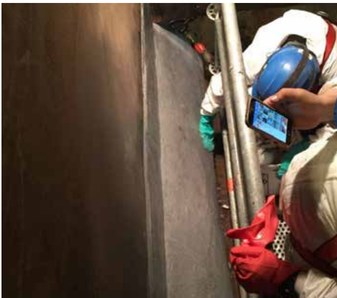
Aplicación del recubrimiento de protección Devcon Dfense Blok, sin necesidad de soldadura.
