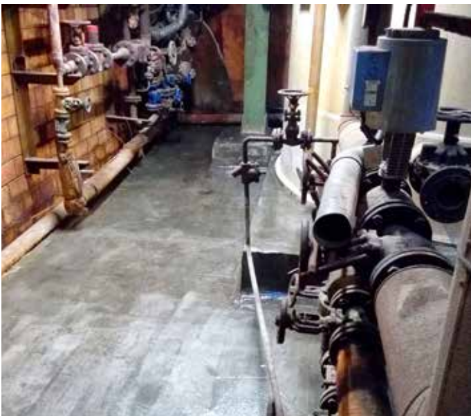
Aplicación de la imprimación sellante DEVCON Epoxy Sealer 100 .
