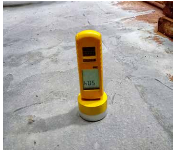
Saneado, limpieza y reconstrucción del hormigón contaminado.
