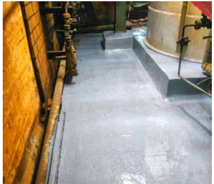
Estado final del cubeto después de aplicar el recubrimiento de protección DEVCON Epoxy Coat 7000AR .
