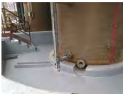
Protección química en cubeto de contención con DEVCON Epoxy Coat 7000 AR.
