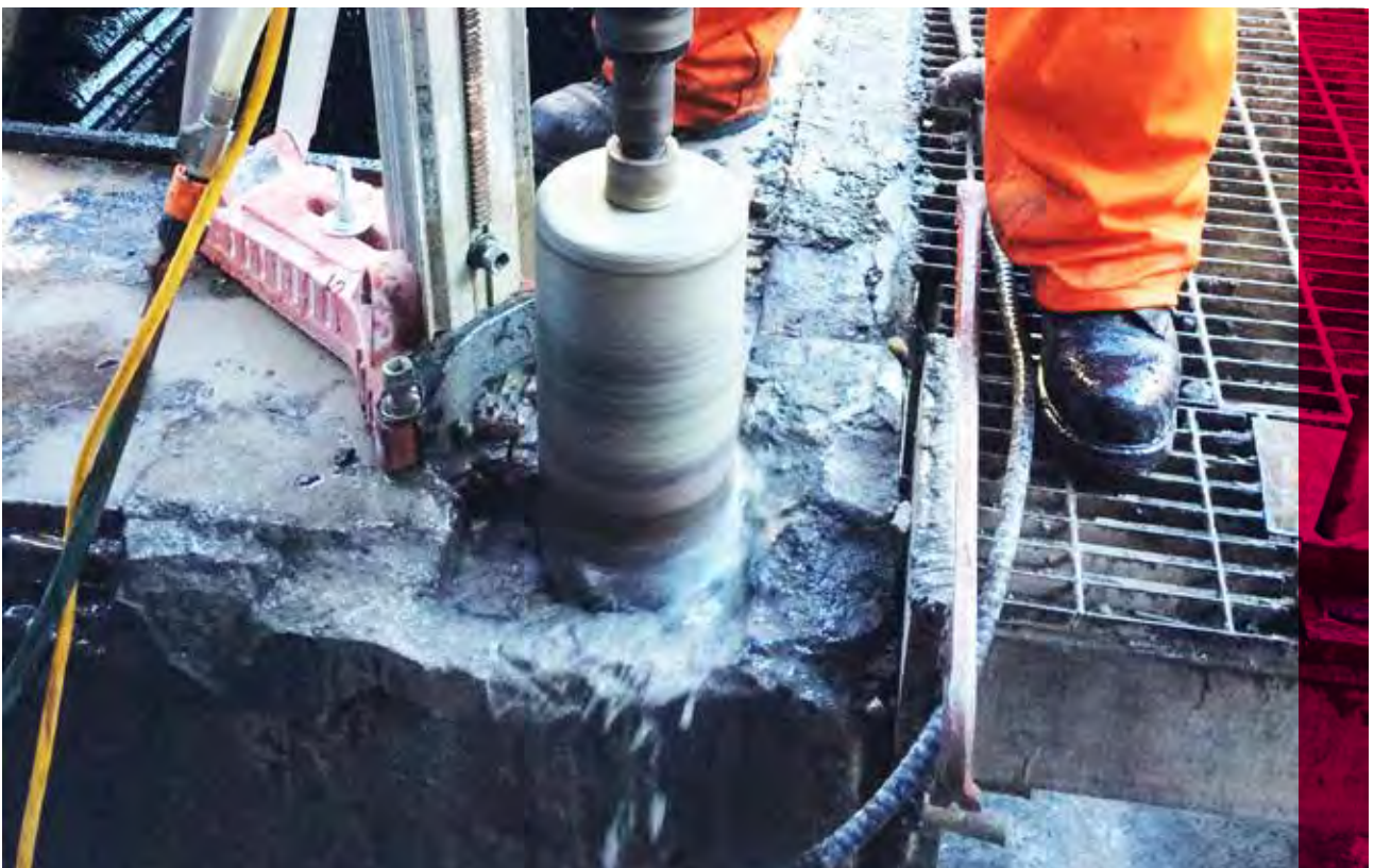
Barrenado para la extracción de pernos.
