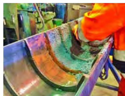
Protección de tubo de alimentación de molino con DEVCON Dfense Blok.
