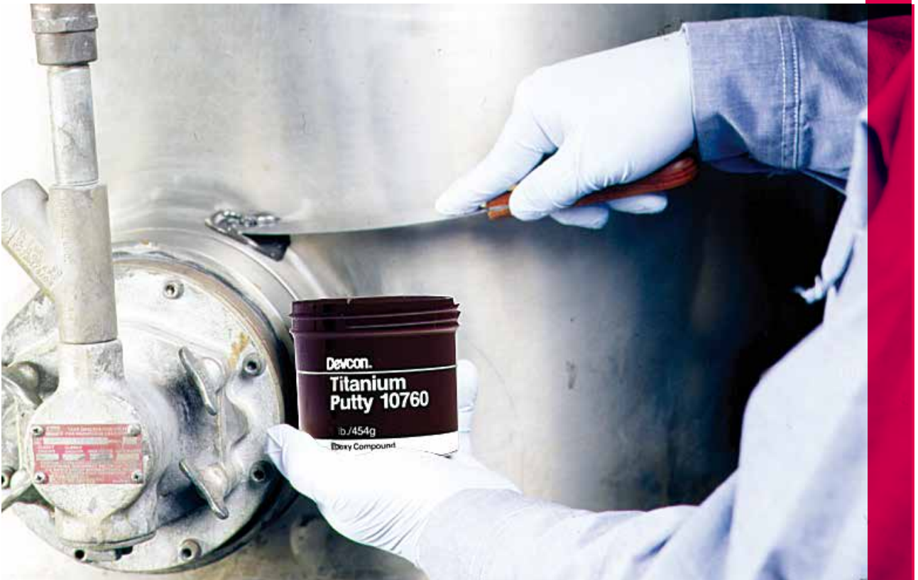
Reconstrucción y protección de equipos industriales.
