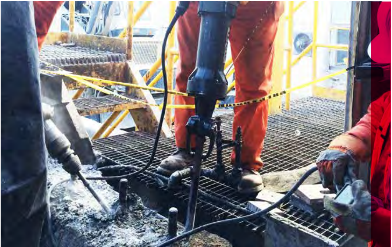
Picado de la cimentación.
