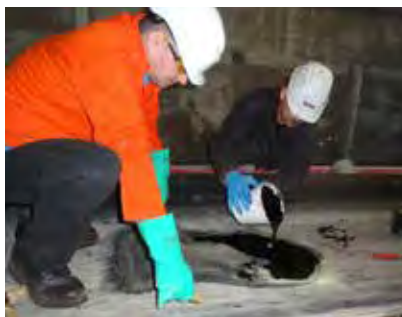
Reparación de bandas transportadoras con DEVCON R-Flex.
