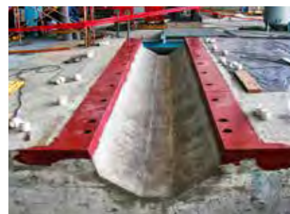
Grouting de un motor con resina Chockfast Rojo.
