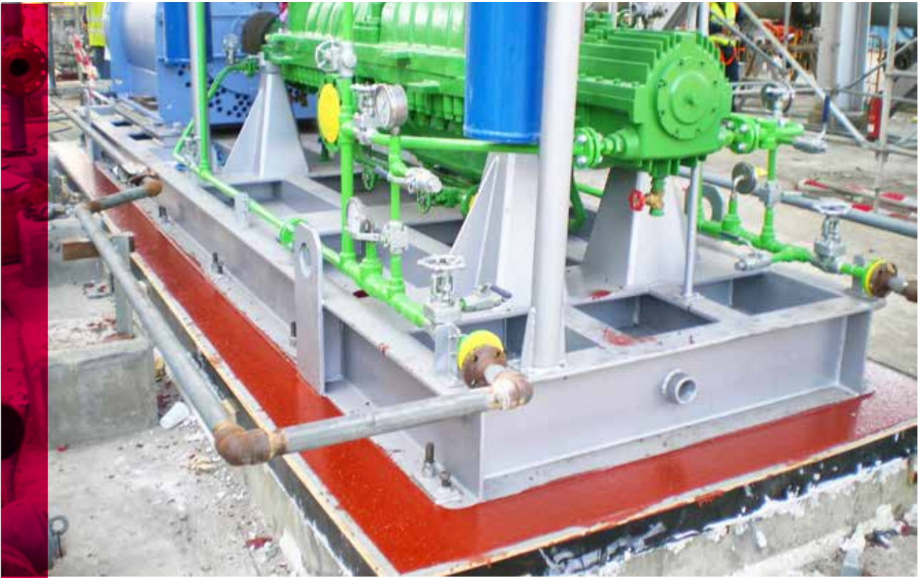
Grouting de una bomba multietapa.
