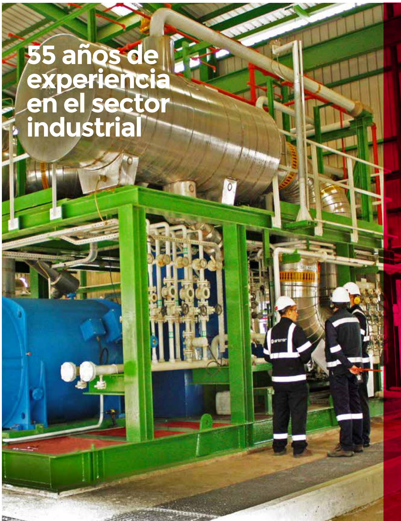
Control del macizado del bastidor de un compresor alternativo.
