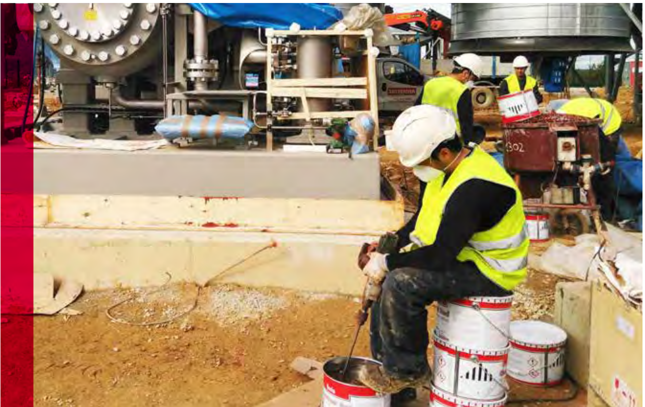
Mezclado de resina para grouting de compresor centrífugo.
