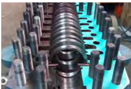
Instalación de nuevos aros de desgaste en bomba multietapa.
