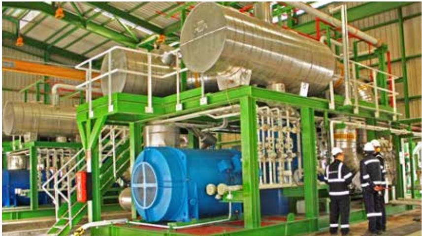
Inspección de compresor alternativo instalado con Chockfast Rojo.
