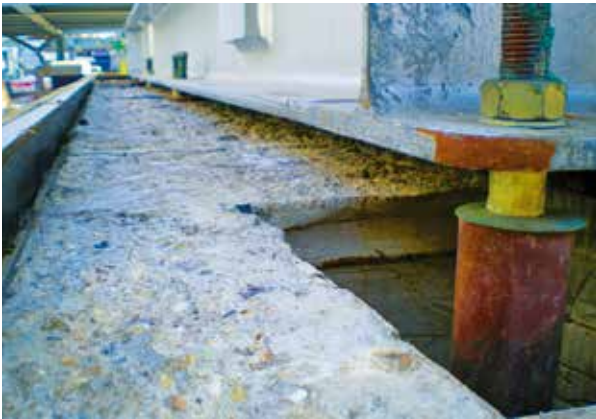
3/ Preparación del equipo previa al vertido.
