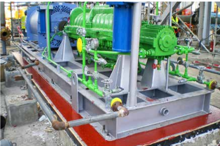
Grouting de motor y bomba multietapa.
