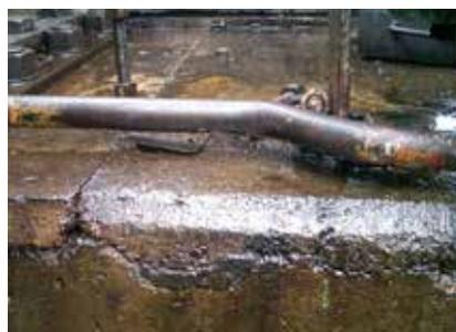
Grout cementoso contaminado y separado de la cimentación.
