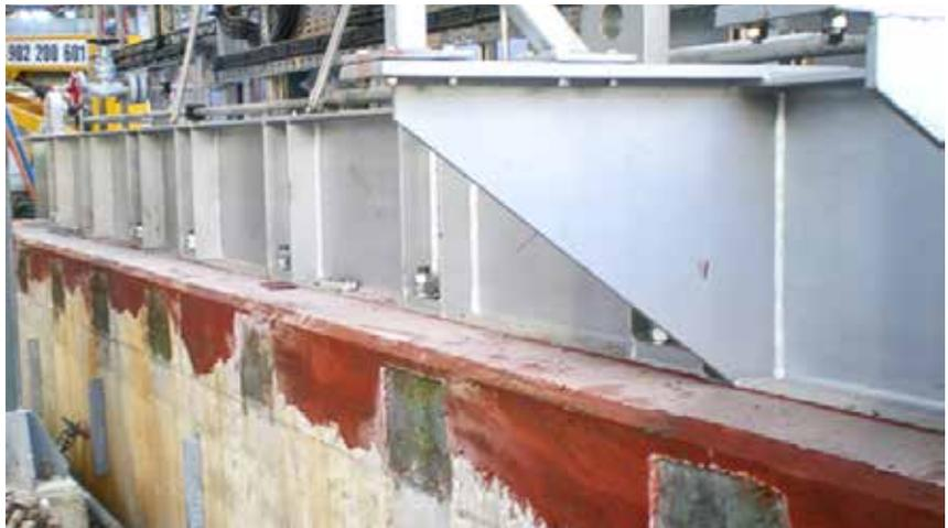
**Detalle del grout y bastidor.**
