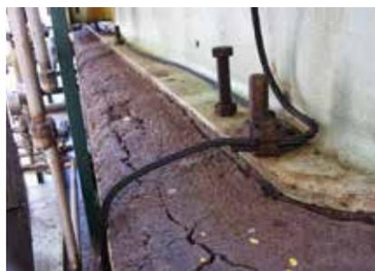
Detalle de grietas en grout cementoso.
