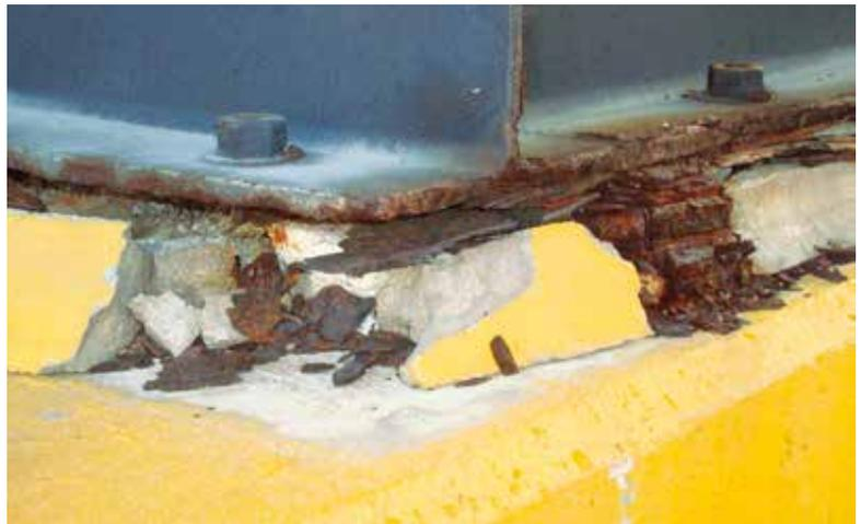
**Rotura del grout cementoso por oxidación de placas.**
