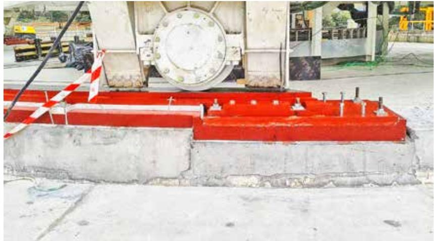
**Pista de rodadura de Antena en una estación de seguimiento de la NASA.**
