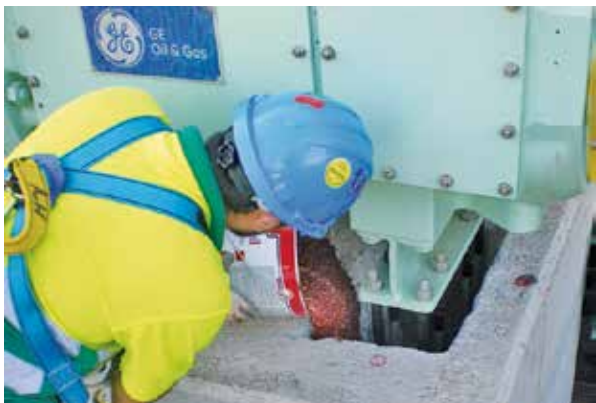
5/ Vertido de grouting, Chockfast Rojo.
