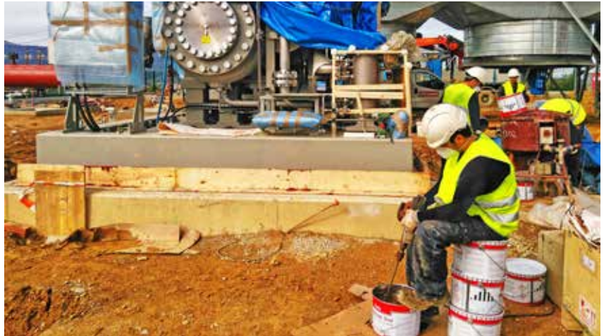
Preparación del mortero Chockfast Rojo para realizar el grouting de un compresor centrífugo.
