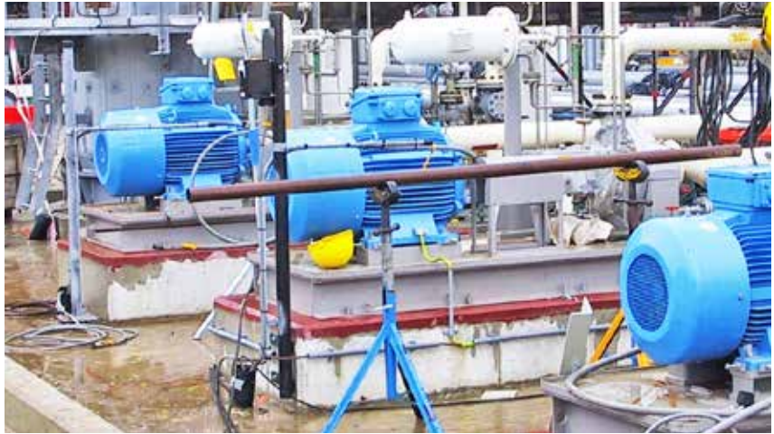
Instalación de bombas en bastidor con grout Chockfast.
