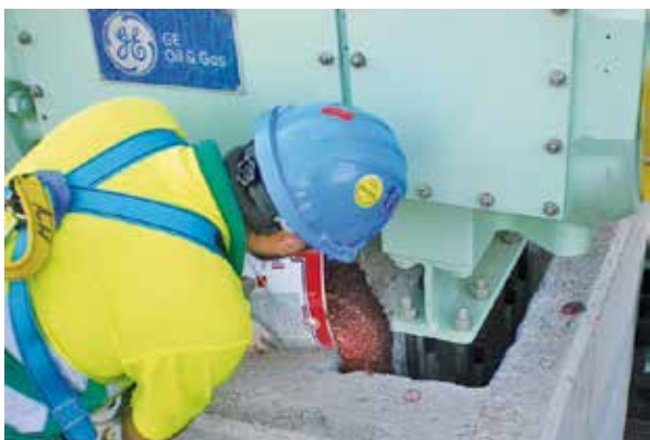
5/ Vertido de grouting, Chockfast Rojo.
