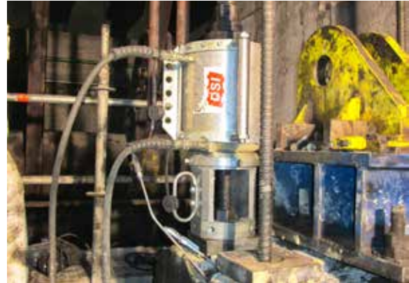
REFUERZOS, Inserción de barras y tensores para el refuerzo.
