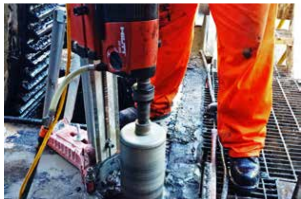
SUSTITUCIÓN DE PERNOS DE ANCLAJE, Barrenado, extracción y sustitución.
