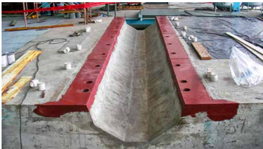
Pregrouting de motor con Chockfast Rojo.
