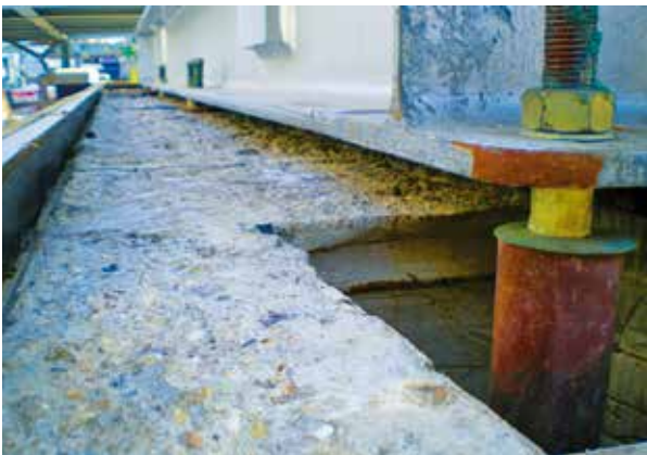
3/ Preparación del equipo previa al vertido.
