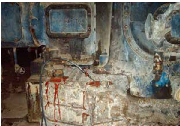
INYECCIÓN EN HORMIGÓN, Inyección de resina epoxi a presión para reparar grietas.
