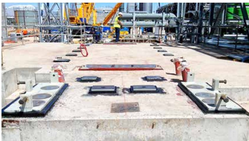
Taqueado de turbina con Chockfast Negro y Rojo.
