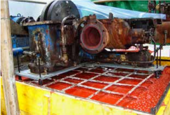
RECONSTRUCCIÓN, Reparación de la bancada de hormigón y re-grouting.
