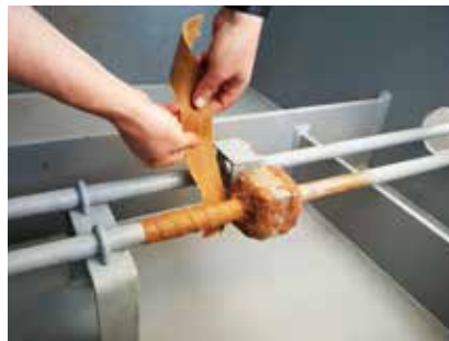
Cinta engrasada para la protección frente a la corrosión.
