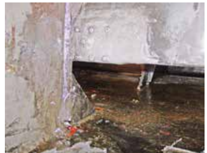
Perforación reparada dentro del tanque de combustible. (Después)
