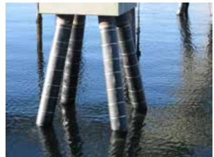
Solución TidalWrap para la protección anticorrosión de pilotes.
