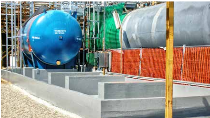
RECONSTRUCCIÓN Y PROTECCIÓN DE SUPERFICIES DE HORMIGÓN, Impermeabilización, regularización y protección contra el ataque químico.
