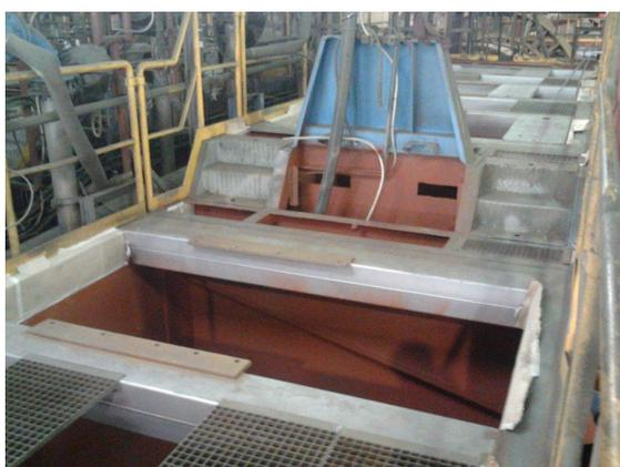
Preparación de la superficie mediante chorreo y posterior imprimación con los productos Irabond para protección contra corrosión y para generar la máxima adherencia.
