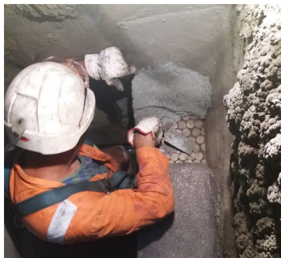
Aplicación in-situ del revestimiento DEVCON DFense Blok para proteger la caja de alimentación de un molino.
