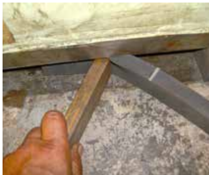
1. Preparación encofrado interior con goma.
