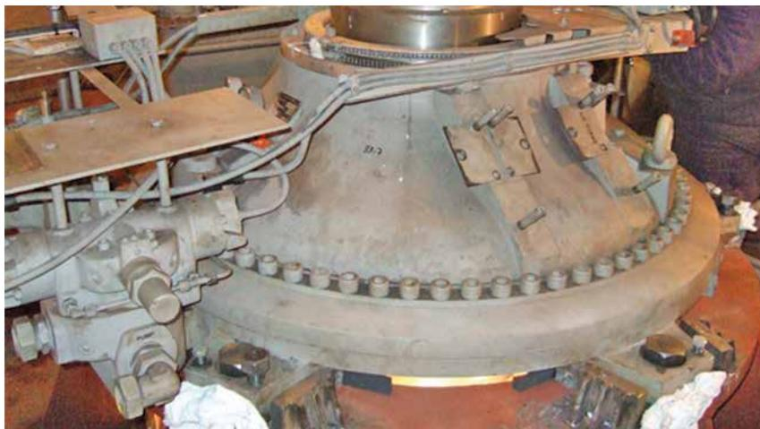
**Instalación de Servomotor con resina Chockfast Naranja.**
