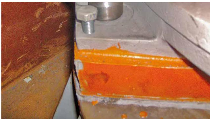
**Detalle del taqueado del Servomotor con Chockfast Naranja.**
