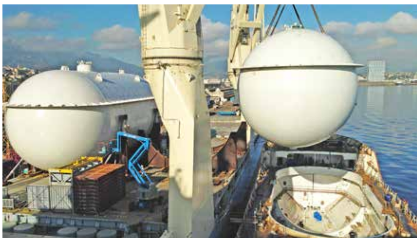
Instalación de depósitos de combustible GNL.
