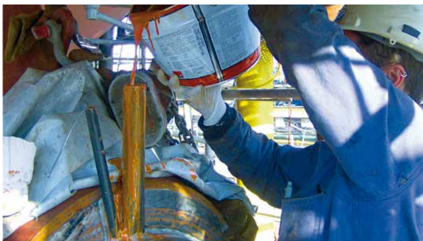
Vertido por gravedad de la resina Chockfast Naranja.
