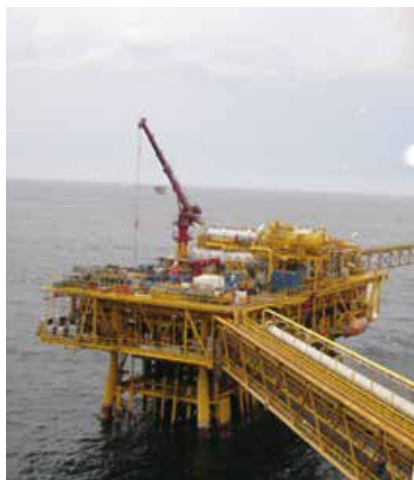
1. Instalación de Compresor en plataforma offshore.
