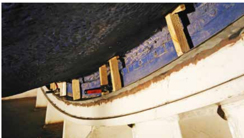
Instalación de depósito GNL con Phillymastic TG-7B .
