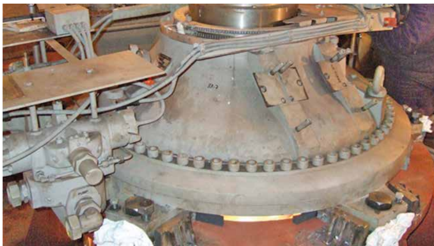
Instalación de Servomotor con resina Chockfast Naranja.
