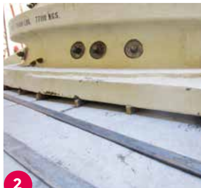
2 La unidad mostraba desprendimiento del grout cementoso, alto grado de oxidación de la placa y agrietado de la columna base.
