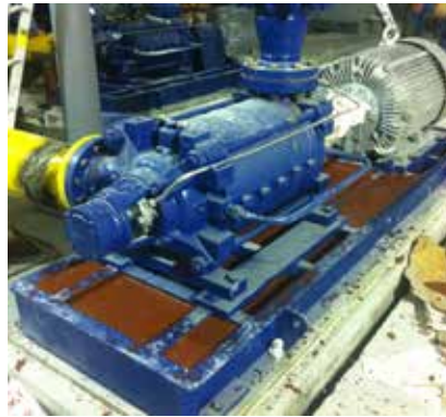
Relleno del skid de dos bombas con la resina epoxi Chockfast Rojo para eliminar las vibraciones que presentaban. La mina "El Roble", México.
