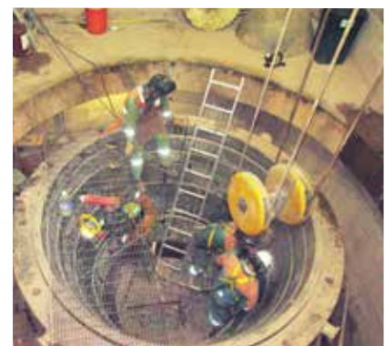
Regrouteo con resina epoxi Chockfast Rojo de la trituradora giratoria METSO por hundimiento de los puntos de apoyo. Unidad "Milpillás", Minera La Parreña, México.
