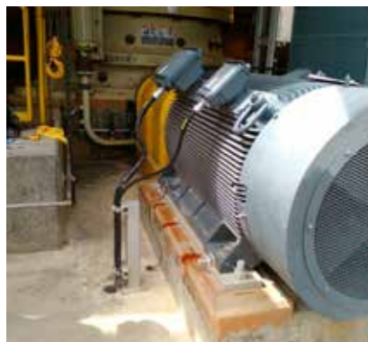
Taqueado de los equipos de trituración y motores eléctricos con la resina epoxi Chockfast Naranja . Mina de metales preciosos "Media Luna", México.
