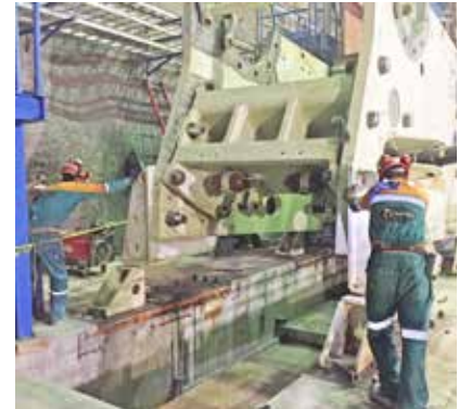
Grouting de los equipos de trituración y sus motores con resina epoxi Chockfast Rojo y Chockfast Naranja . Unidad "Tayahua", Zacatecas, México.
