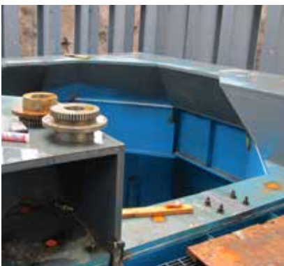
Instalación y montaje de una quebradora giratoria primaria con Chockfast Naranja . Unidad "El Coronel", Minera Real de Ángeles, México.
