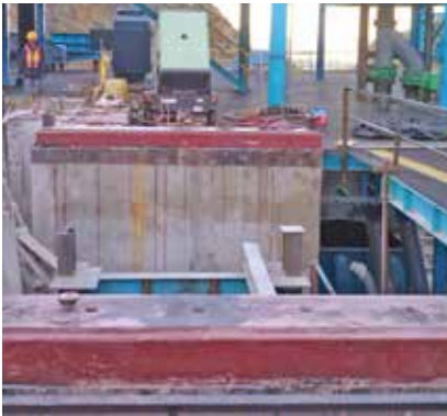
Instalación de base de molino con la resina epoxi Chockfast Rojo . Unidad minera "San Francisco del Oro", México.
