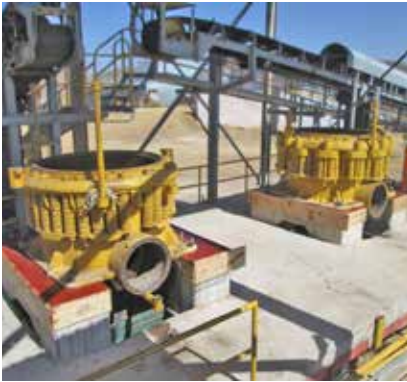
Preparación de nuevos barrenos para los pernos de anclaje y re-grouteo con resina epoxi Chockfast Rojo de las trituradoras por cambio de ubicación. Unidad minera "La Plata", México.
