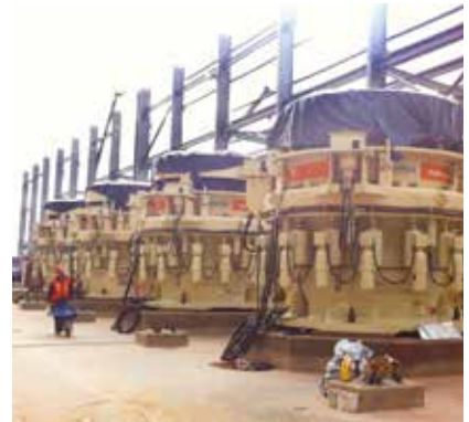
Fijación de 14 trituradoras con la resina epoxi Chockfast Rojo . Proyecto de ampliación de la mina "Buenavista del Cobre", Cananea, México.
