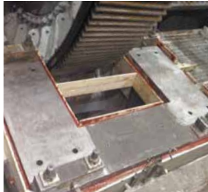
Rehabilitación de las cimentaciones de apoyo de los piñones de 6 molinos con la resina epoxi Chockfast Rojo . Mina "Buenavista del Cobre", Cananea, México.
