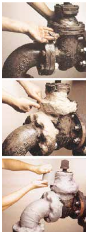
Proceso de instalación de la cinta PetroWrap
