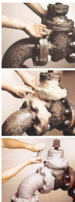
Proceso de instalación de la cinta PetroWrap
