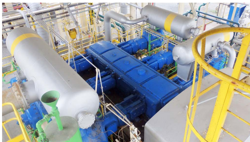
Trabajo de mantenimiento en compresor alternativo.
