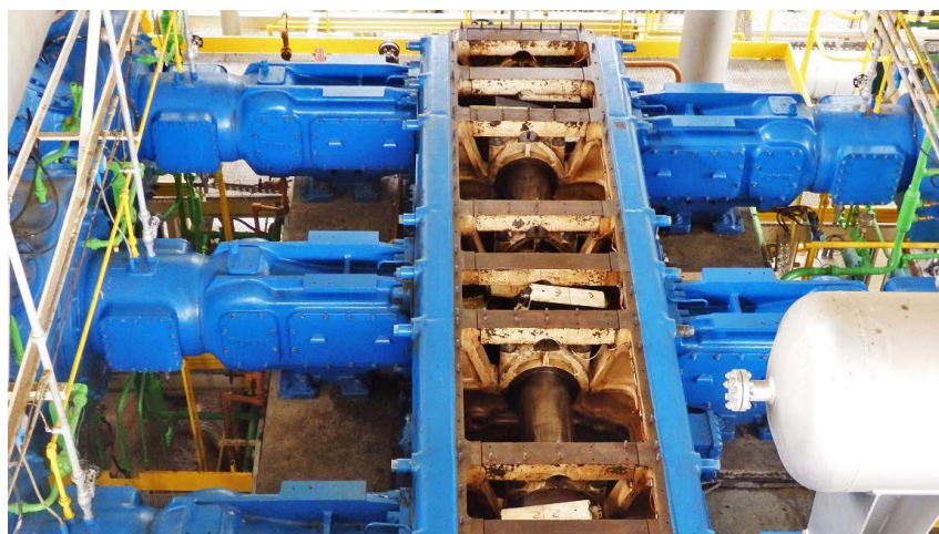
Detalle del compresor alternativo en proceso de mantenimiento.
