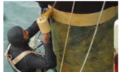
Imprimación y colocación de la cinta
