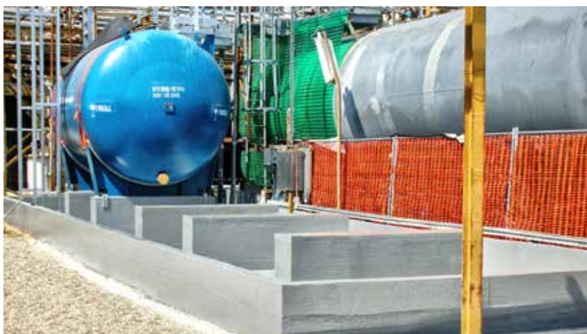
RECONSTRUCCIÓN Y PROTECCIÓN DE SUPERFICIES DE HORMIGÓN, Impermeabilización, regularización y protección contra el ataque químico.
