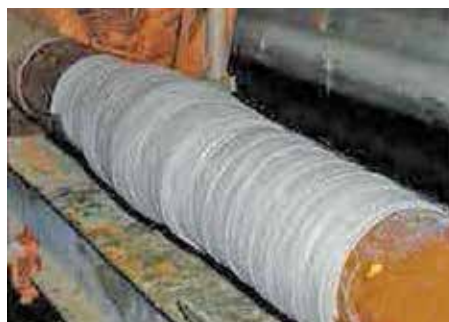
Tubería reparada con Pow-R Wrap sin necesidad de utilizar herramientas.
