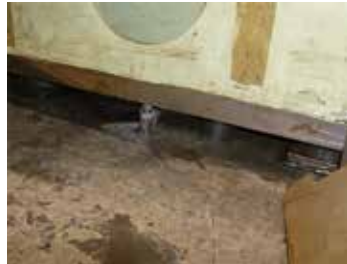
1. Preparación encofrado interior con goma
