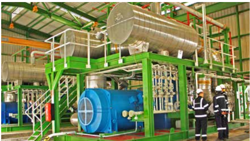
Inspección de compresor alternativo instalado con Chockfast Rojo.
