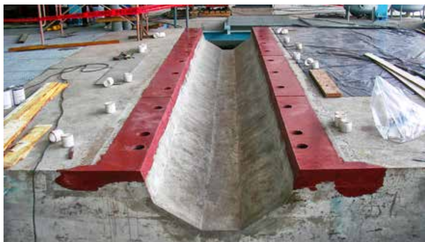
Grouting de motor con Chockfast Rojo.
