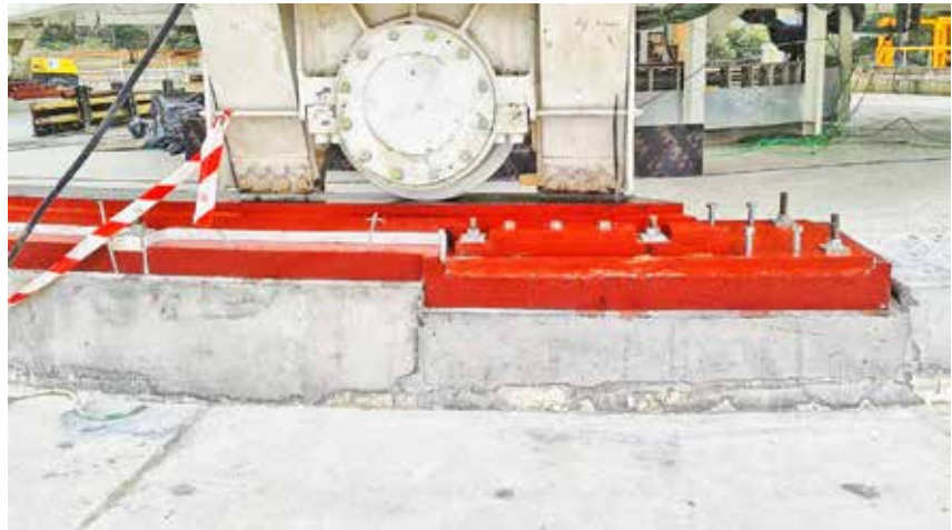
Pista de rodadura de Antena de la NASA.
