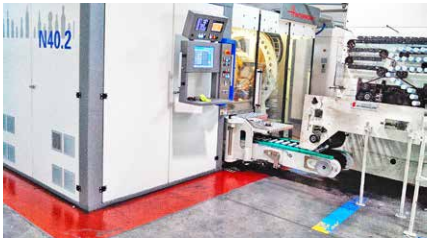
Grouting de conformadora.
