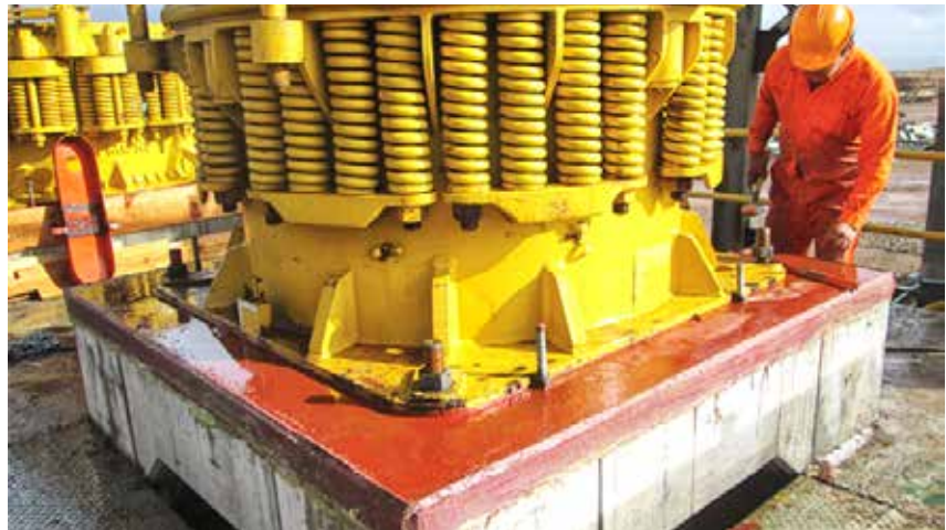
Extracción de pernos y grouting de trituradora de cono.
