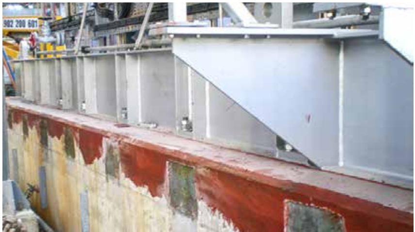
Detalle del grouting y bastidor.
