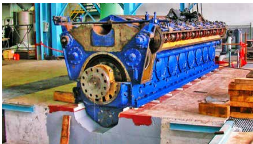
Motor sobre grouting de Chockfast Rojo.
