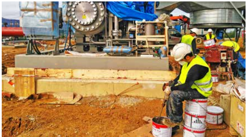
Preparación del mortero Chockfast Rojo en grouting de compresor centrífugo.
