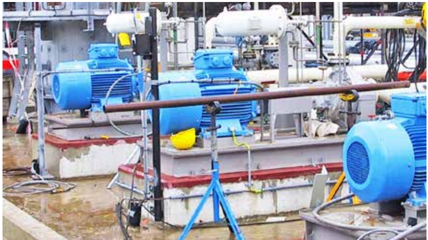
Instalación de bombas en bastidor con grouting Chockfast.
