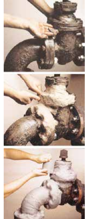
Proceso de instalación de la cinta PetroWrap
