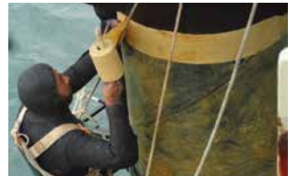
Imprimación y colocación de la cinta
