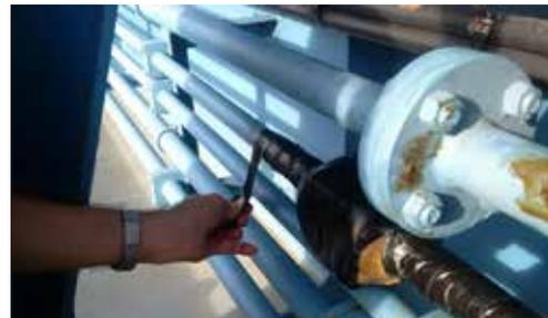
Recubrimiento externo como protección mecánica y frente a los rayos UV (opcional).
